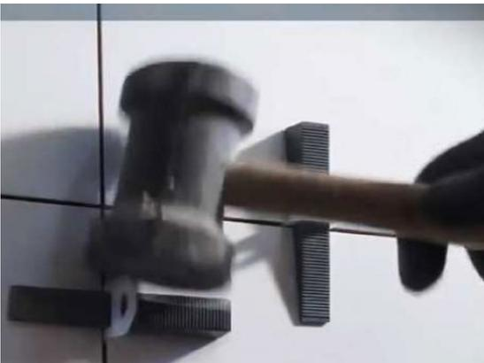
La parte superior de la base se romperá liberando la cuña, que puede ser recogida para reutilización. Después de este paso, basta realizar la limpieza de las partes sueltas y continuar con el rejuntado.
