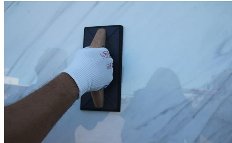
Para una mejor manipulación de la pieza se recomienda el uso de bastidor o ventosas así como el uso de una llana de goma para evitar los huecos y burbujas de aire.
