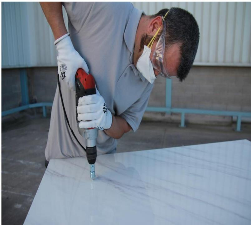
**Emplear puntas diamantadas, de cristal o de gres porcelánico para perforaciones de entre 8-10mm**
