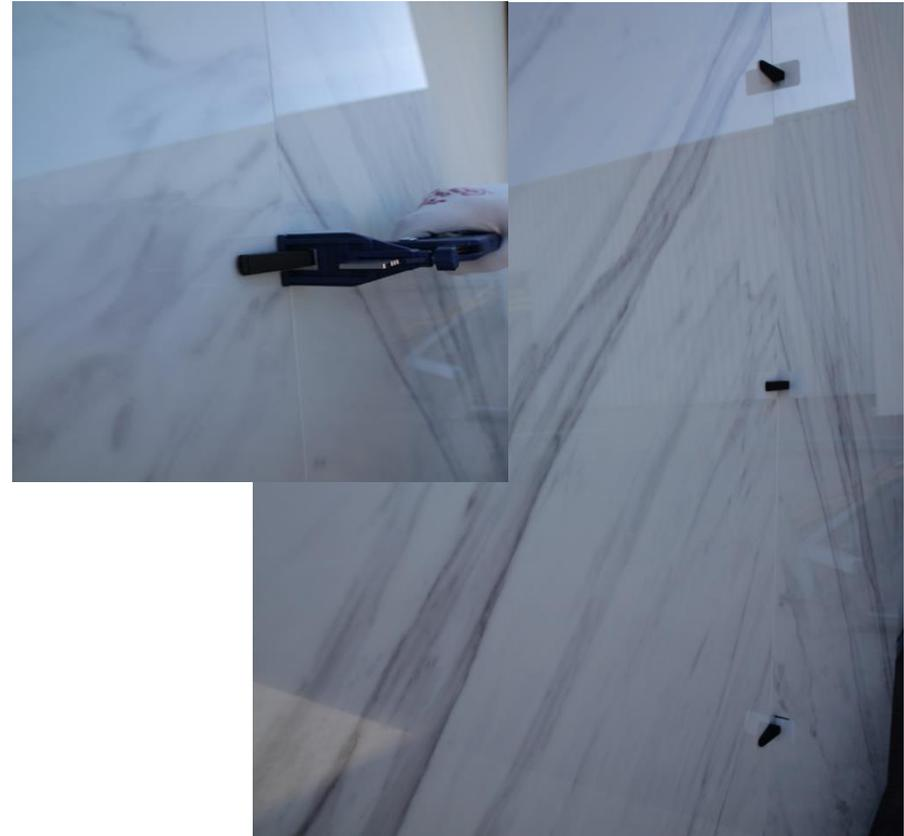
**Emplear las cuñas autonivelantes y las crucetas de separación. Es recomendable el uso de juntas de 2mm entre pieza y pieza para interior y de 5mm para exterior**
