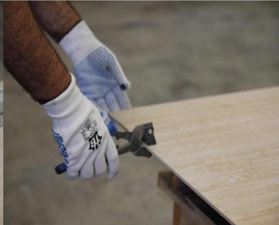
**Mover la lámina B|PLUS hacia el final del banco a modo que la pieza sobresalga unos 10-15 cm. Con la ayuda de la tenaza de corte, ejercer una leve presión sobre la pieza**
