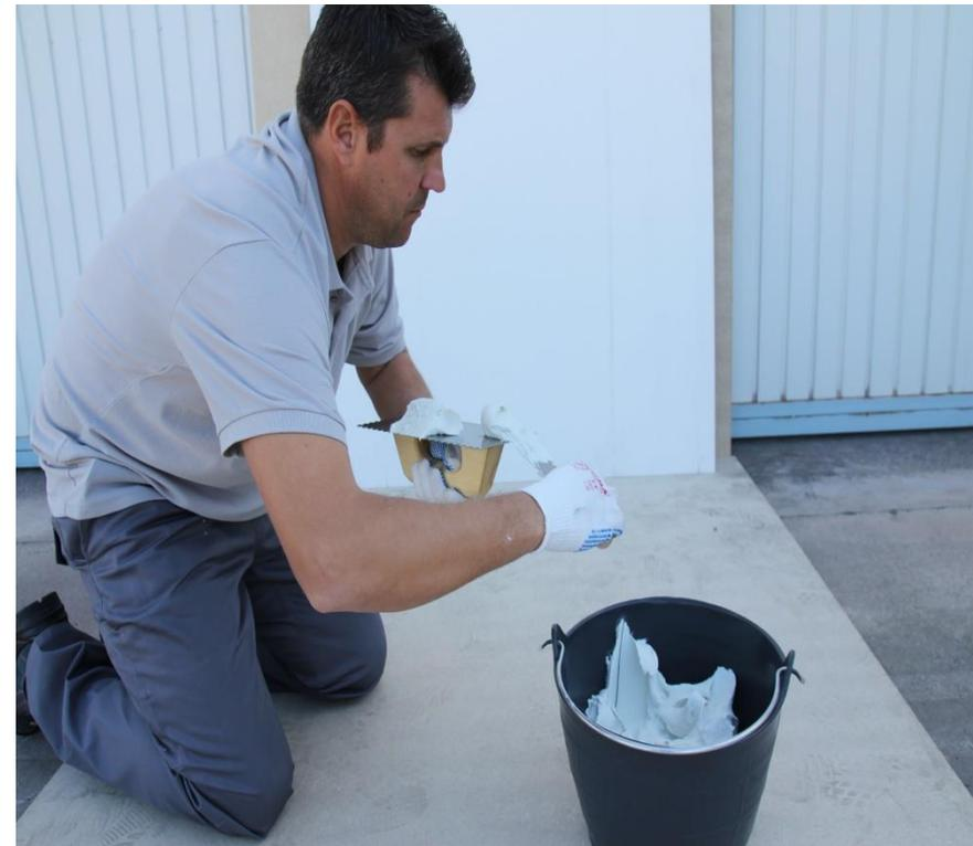
**Aplique el cemento cola sobre una llana dentada de aproximadamente 3x3mm. Extienda la cola por toda la pieza, siempre en la misma dirección y haciendo hincapié sobre los ángulos de la pieza.**
