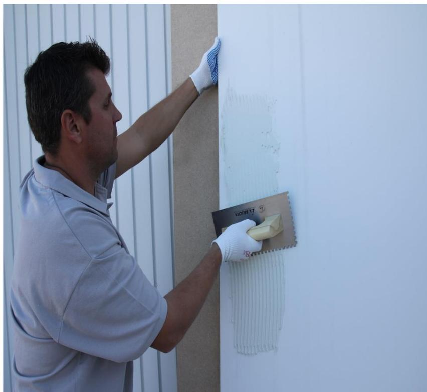
Después, extienda la cola sobre el solado excediendo unos 5-10cms más con respecto al tamaño de la pieza para garantizar una óptima colocación.
