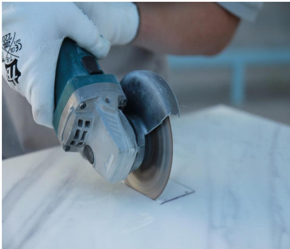
**Proceder al corte de las líneas marcadas con un disco de diamante. Para finalizar, eliminar la pieza sobrante y colocar el aplique deseado.**
